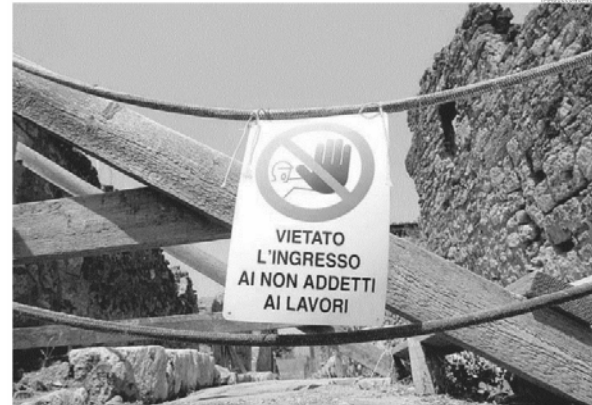
Lavori. Le aree interdette e bisognose di restauri all'interno del sito archeologico di Pompei
