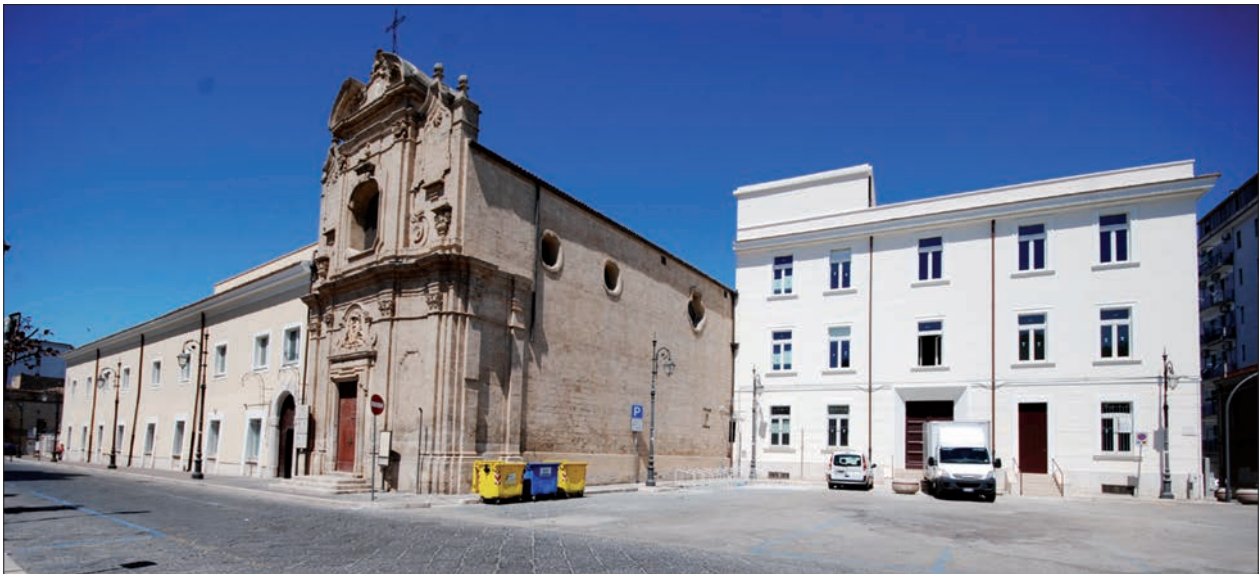
3. - La sede del Dipartimento di studi umanistici al termine dei lavori di recupero (foto Fabio Iascone, Università di Foggia).
