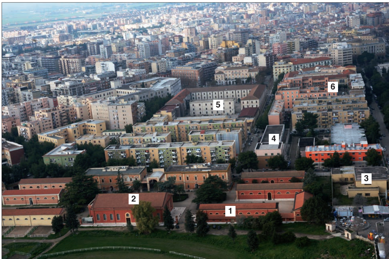
21. - Veduta aerea del complesso ex IRIIP, sede del Dipartimento di Economia (1) e dell'Aula Magna dell'Ateneo (2); in basso a destra la ex-Palestra GIL di via Galliani (3), al centro la ex-Palestra-Piscina GIL di via Amm. Da Zara (4), la Caserma Miale (5), l'ex Tribunale, sede del Dipartimento di Giurisprudenza (6) (foto Comando Provinciale dei Carabinieri, Foggia; cortesia col. Antonio Basilicata).
