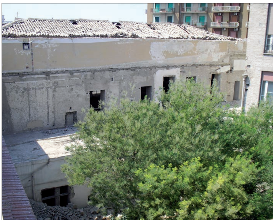
10. - Veduta di uno dei corpi di fabbrica degli ex Ospedali prima dei lavori di recupero; ora ospita l'aula magna e le aule del DISTUM (foto Fabio Iascone, Università di Foggia).
