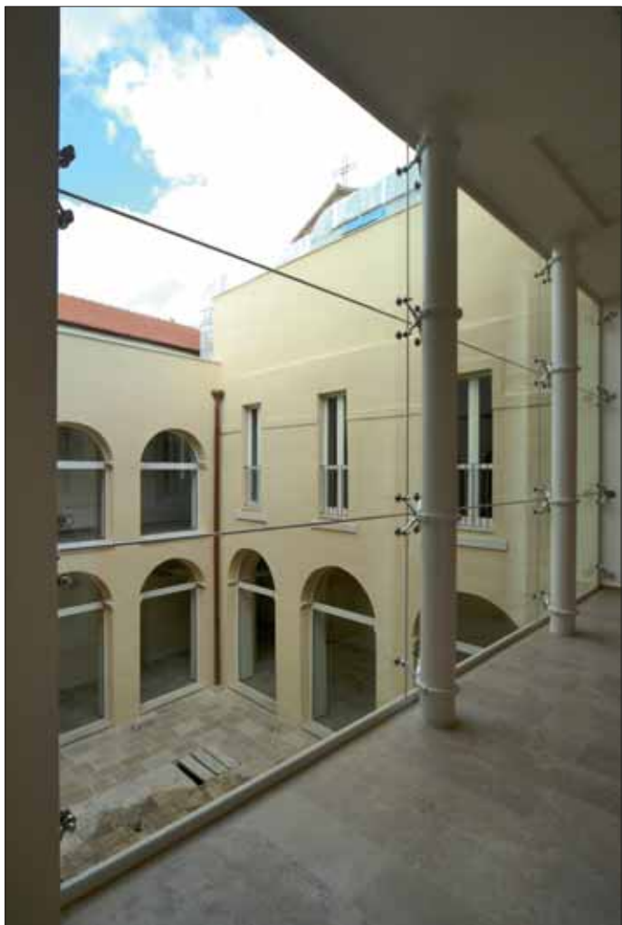
Un particolare del chiostro del convento di Santa Caterina ritrovato durante i lavori di restauro (foto Mimmo Attademo).
