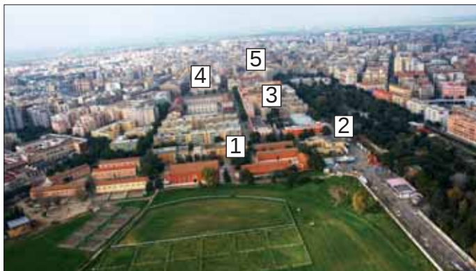
Veduta aerea dell'IRIIP (Istituto regionale di incremento ippico) (1), in parte già ristrutturato e utilizzato dall'Università per l'aula magna e la sede del Dipartimento di Economia. Si notano a destra e in alto le Palestre ex GIL di via Galliani (2) e di via Amm. Da Zara (3), la Caserma Miale (4) e l'ex Tribunale (5) (foto Comando Provinciale Carabinieri, Foggia).
