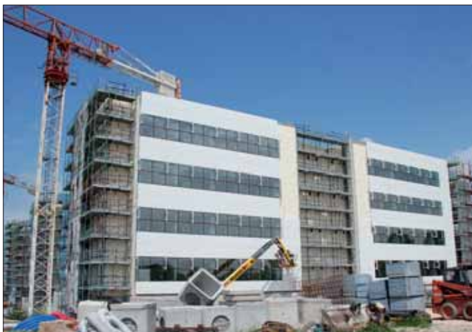
Cantiere della nuova sede della Facoltà di Medicina (maggio 2013).
